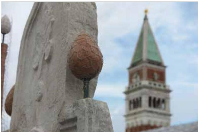
PG-DEBRIX® ist ein dreifach verdrehtes sechseckiges Maschendrahtgeflecht, Edelstahldraht. Es wird zum Schutz und zur Erhaltung alter Gebäude und historischer Architektur verwendet.
